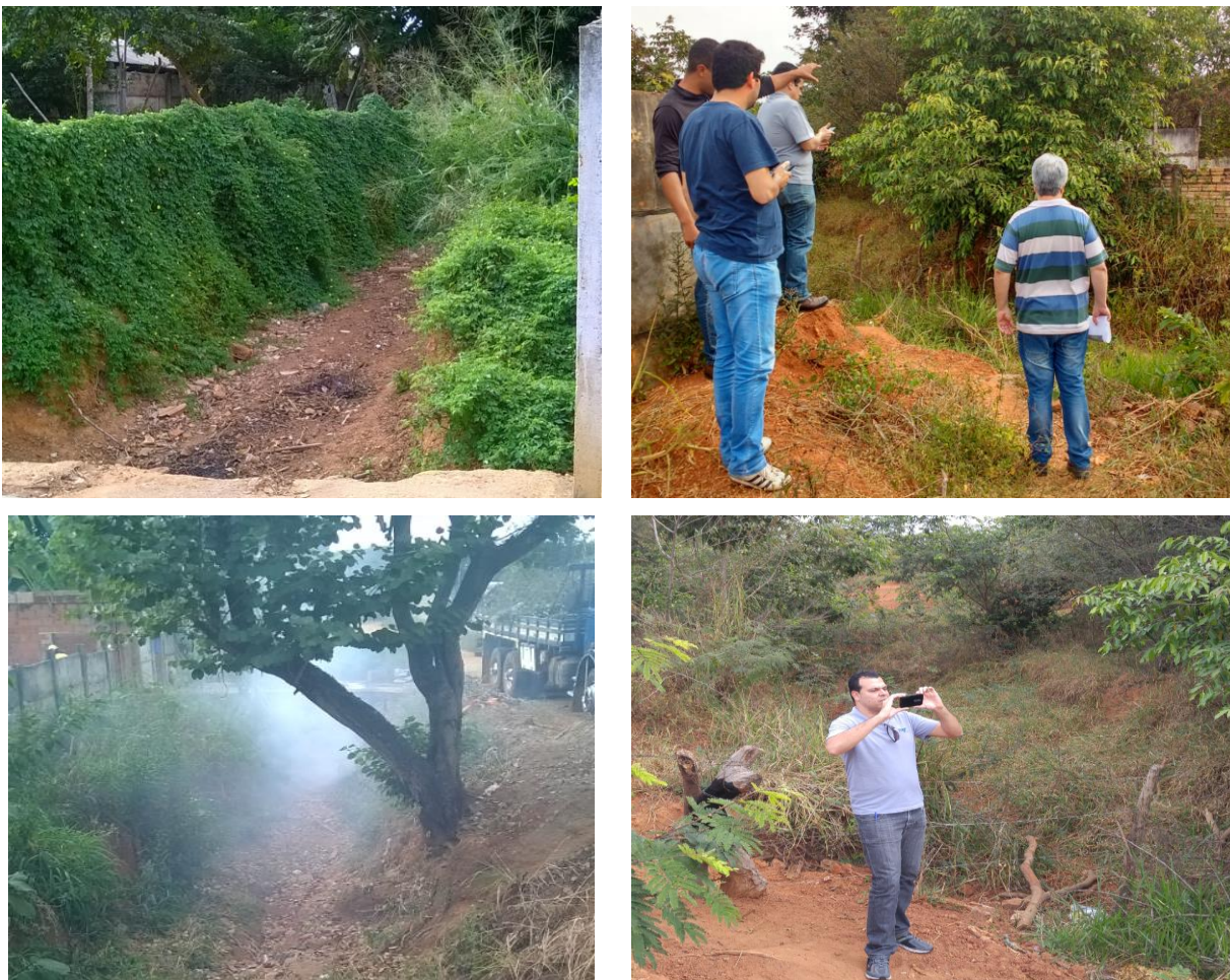
Figura 11: imagens dos fundos de vale da cidade de Corinto, completamente secos e impactados. Fonte: Myr projetos, 2016.
